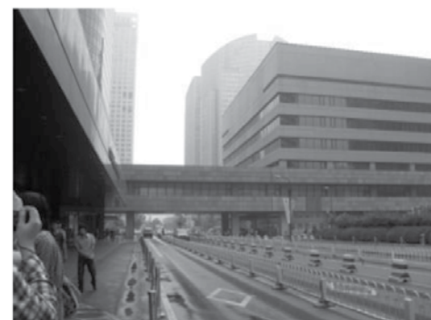
高层建筑下部开口
