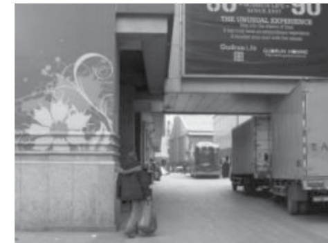
高层建筑下部开口
