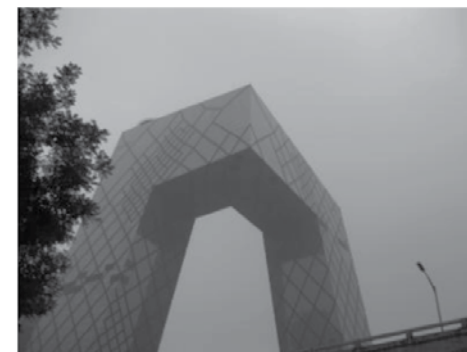
高层建筑下部开口
