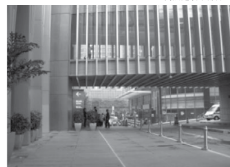
高层建筑下部开口
