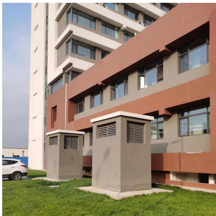
图 4-5 地下车库排风口
