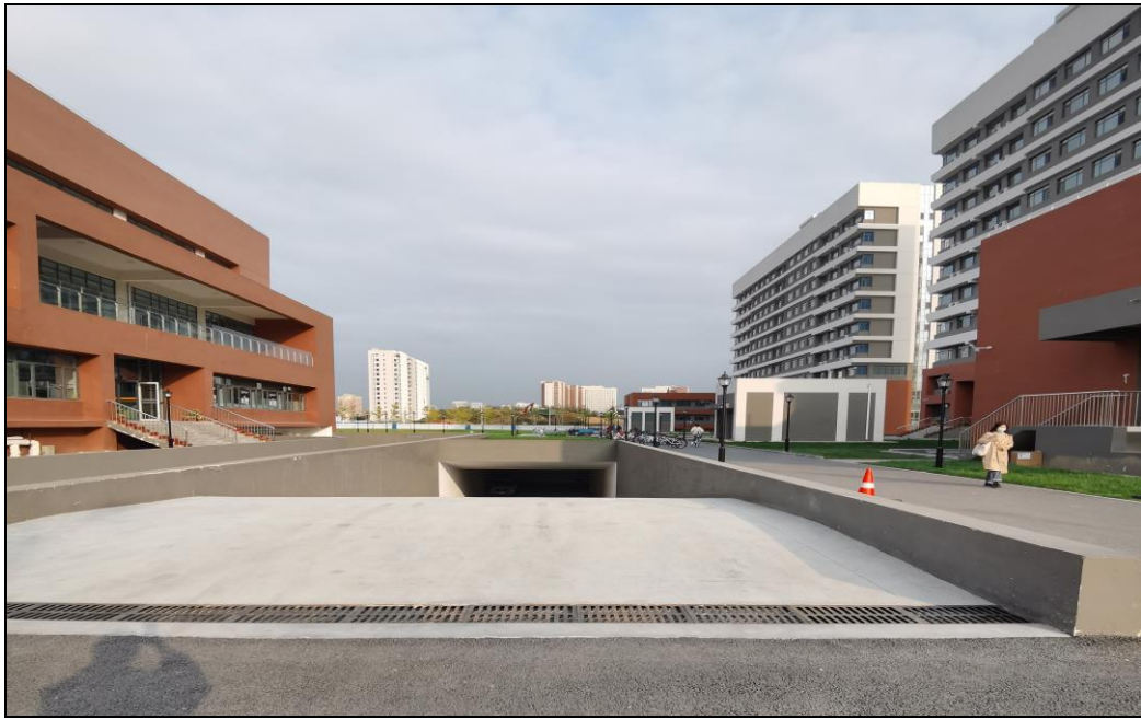
图 3-8 大学生公寓 7 号楼地下车库入口
