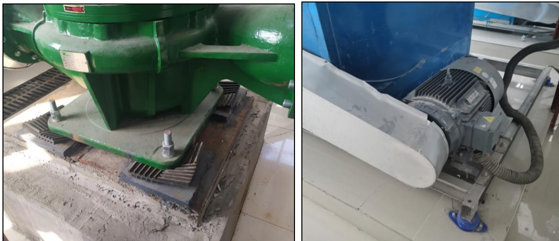
图 4-8 减震基础
