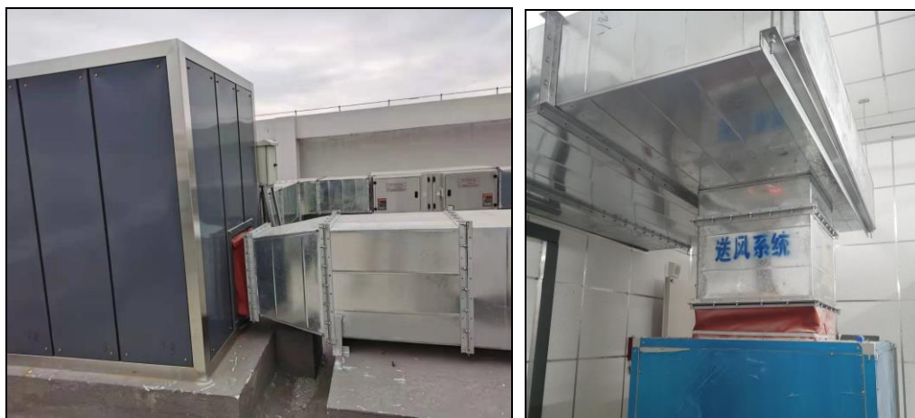
图 4-9 风管软连接
